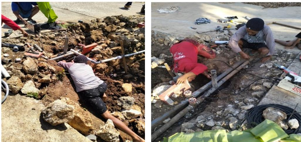
Gambar 7 dan 8. Perbaikan Pipa Plastik
